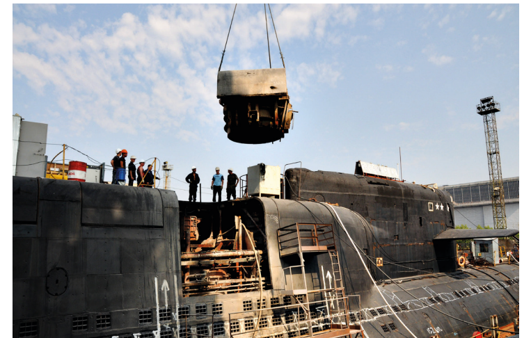
фрагмент ракетной шахты АПЛ, вырезанный гидрорезным оборудованием РФЯЦ-ВНИИТФ
